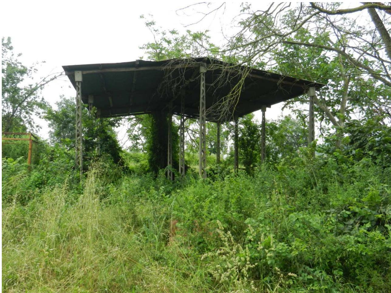
Figura 12 - vista della tettoia costituita da struttura in elevazione prefabbricata, travi in legno e copertura in ondulato metallico
